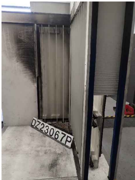
Foto 3: DZ3.1/23-067P („V-200“), Ansicht des Luftspalts des großen Flügels vor der Brandprüfung.
