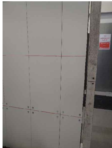
Foto 18: Prüfkörper DZ3.1/23-067N („K-284“), Detailansicht der Außenkante des breiten Probenflügels in Höhe von 500 mm in einem Winkel von ca. 45° vor der Brandprüfung.
