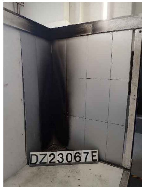
Foto 8: Prüfkörper DZ3.1/23-067E („K-284“), Ansicht nach der Prüfung.
