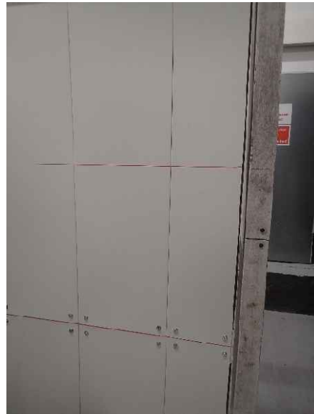
Foto 14: Prüfkörper DZ3.1/23-067M („K-284“), Detailansicht der Außenkante des breiten Probenflügels in Höhe von 500 mm in einem Winkel von ca. 45° vor der Brandprüfung.
