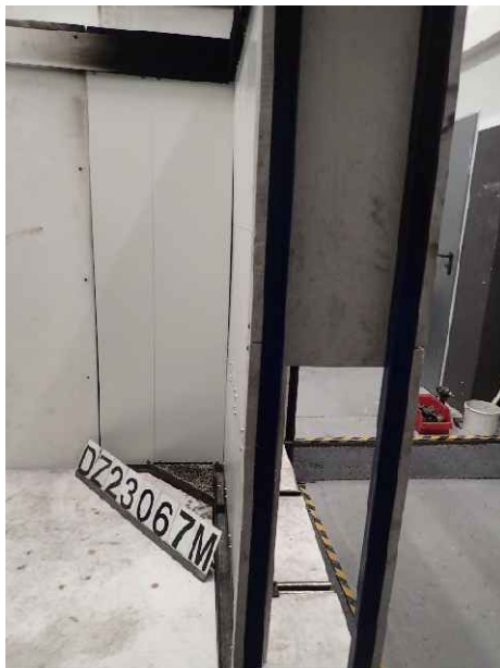
Foto 15: DZ3.1/23-067M („K-284“), Ansicht des Luftspalts des großen Flügels vor der Brandprüfung.
